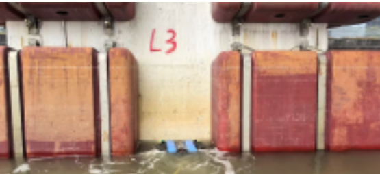
水下检测机器人正在作业
