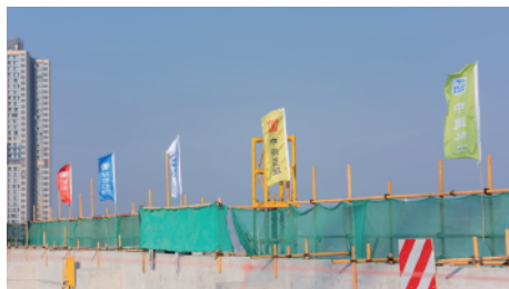
麦捷科技智慧园三期项目建设顺利封顶
