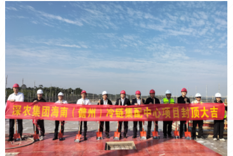
海南（儋州）冷链集配中心代建项目一期工程主体结构正式封顶
