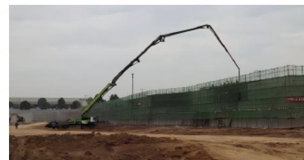
西南海吉星智慧产业园项目挡墙主体浇筑顺利完成
