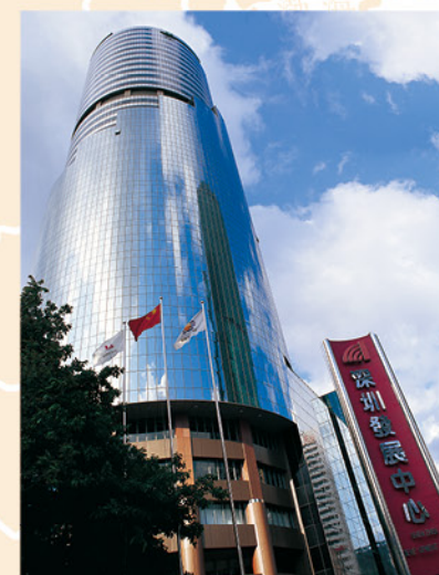
全国第一座玻璃幕墙钢结构大厦 深圳发展中心大厦
